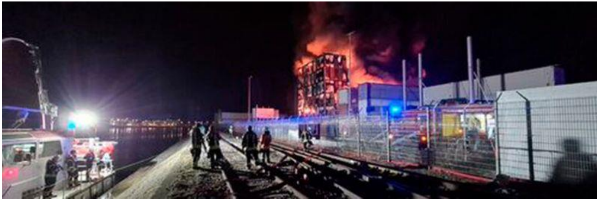
Abbildung 1 - Brand des OVH-Rechenzentrums; © Feuerwehr Kehl
