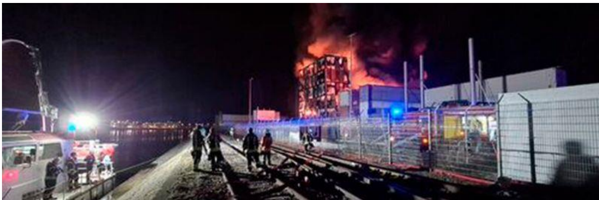
Abbildung 1 - Brand des OVH-Rechenzentrums; © Feuerwehr Kehl
